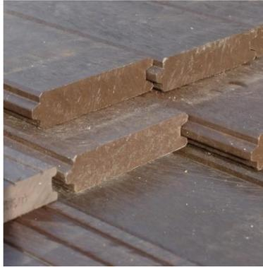
**Figura 21. Duela prefabricada, note las uniones entre elementos y de ser posible utilice este tipo de sistemas.**
