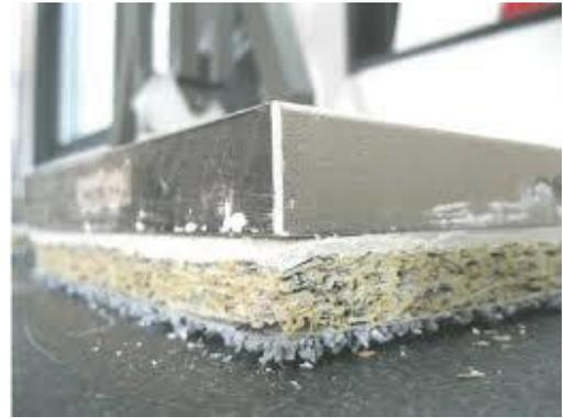
**Figura 22. Piso flotante tipo b.**
